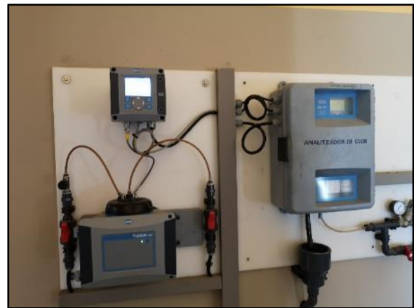
Foto 8 - Analitzadors de clor
