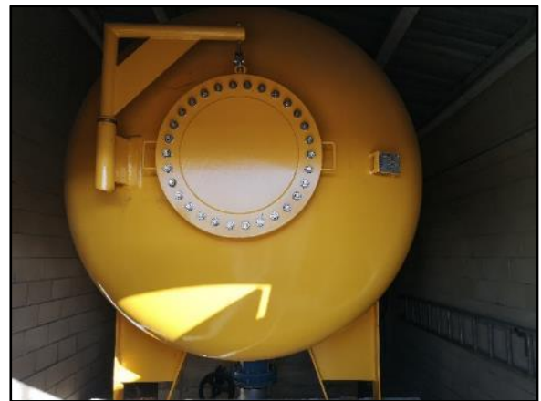
Foto 14 - Calderí anti-arriet
