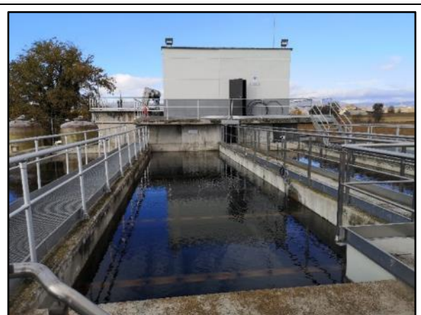
Foto 6 - Vista dels decantadors
