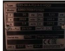
Foto 29 - Bombeig de Vilar Nou a Sant Agustí del Lluçanès i placa de la bomba.
