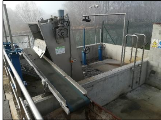
Foto 4 - Desbasts de la captació OSONA SUD
