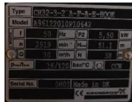
Foto 30 - Bombeig de Vilar Nou a La Serra i placa de la bomba.
