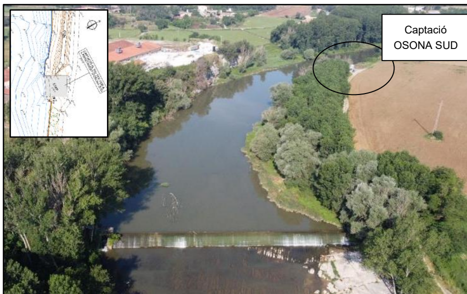
Foto 2 - Vista aèria de la resclosa de Malars - Riu Ter
