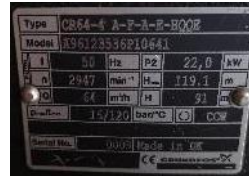
Foto 27 - Bombeig de Vilaseca a Vilar Nou i placa de la bomba.
