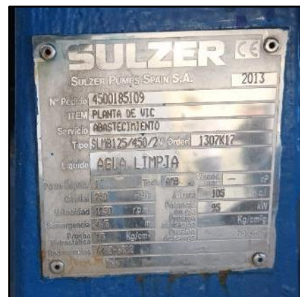
Figura 15. Placa de les bombes de Sant Marc
