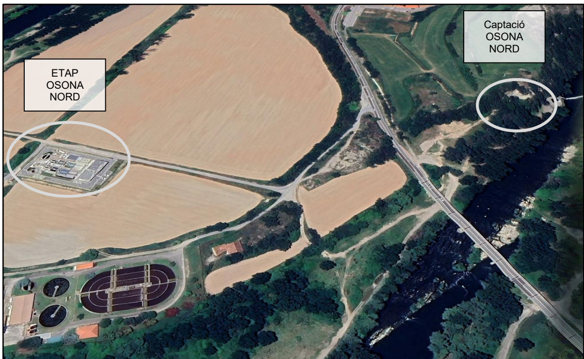
Foto 15 - Vista aèria de captació OSONA NORD - Riu Ter
