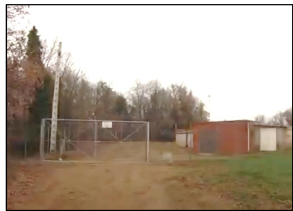
Figura 10. Vista de l'entrada dipòsit de Montrodon.
