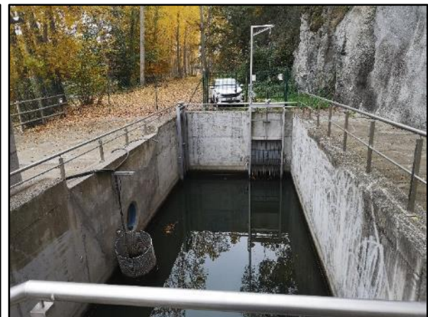
Foto 17 - Dessorrador de la captació OSONA NORD
