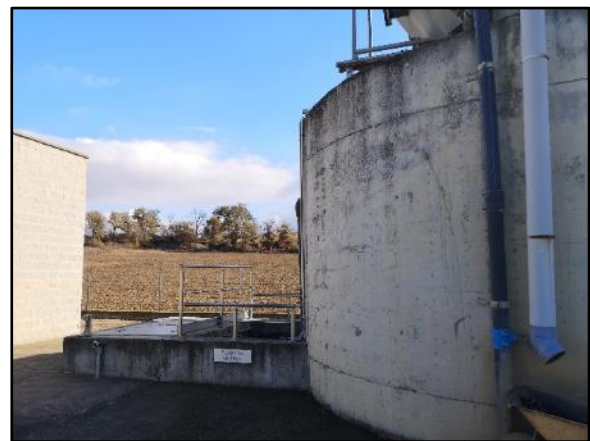
Foto 12 - Espessidor de fangs
