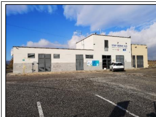
Foto 5 – Vista general de l'ETAP
