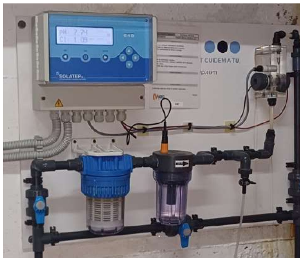
Sistema de cloració existent piscina petita.
