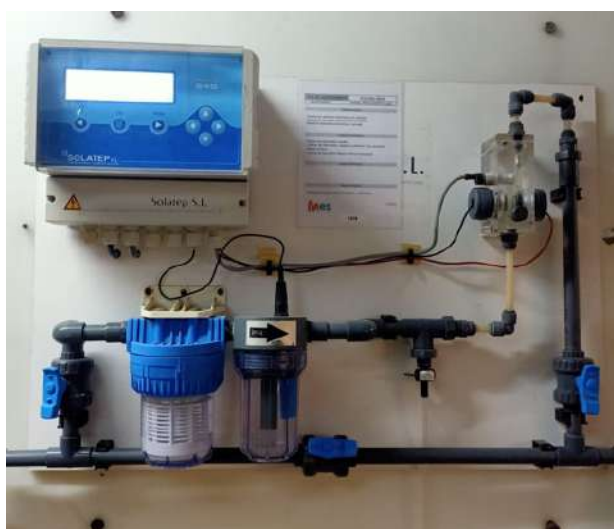
Sistema de cloració existent piscina gran.
