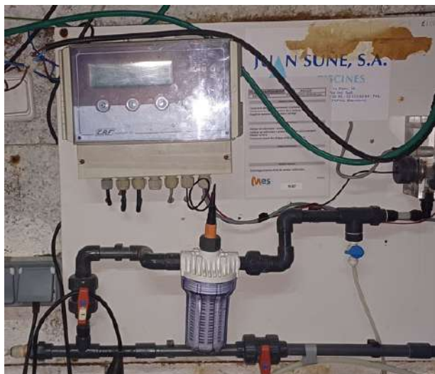
Sistema de cloració existent jacuzzi.
