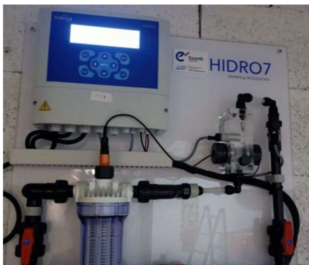
Sistema de cloració existent piscina estiu.
