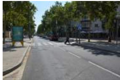
Imatge 9. Pas de vianants de l'Avinguda Ramon d'Olzina
