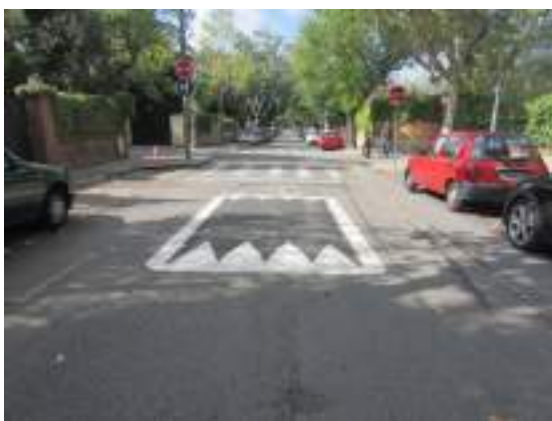
Imatge 36. Exemples de coixins berlinesos d'asfalt.
