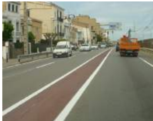
Imatge 35. Exemple en què s'ha establert una mitjana pintada, estrenyent els carrils de circulació.
