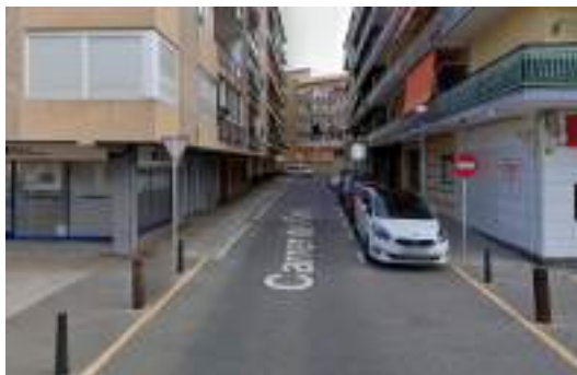
Imatge 59. No s'ha senyalitzat amb fletxes l'elevació de la calçada.
