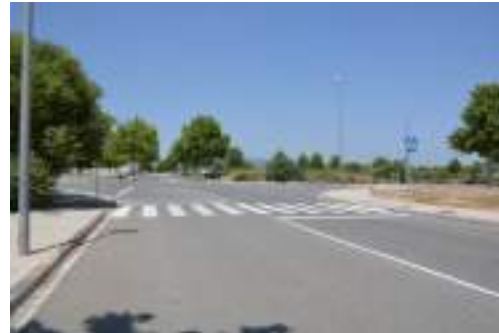
Imatge 6. Carrer de Vilagrassa, senyalització del pas de vianants
