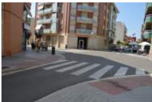
Imatge 41. Tots els guals dels passos de vianants de la intersecció estan dotats de itinerari podotàctil.
