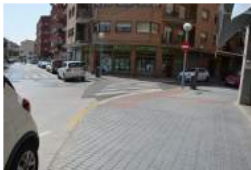
Imatge 48. S'han ampliat les orelles i creat itineraris podotàctils als passos de vianants, apropant també el pas a la intersecció
