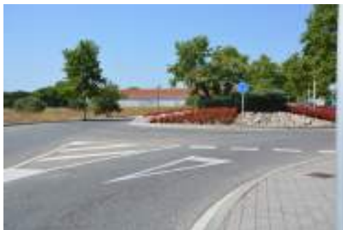
Imatge 10. Falta de visibilitat, Avinguda Ramon d'Olzina
