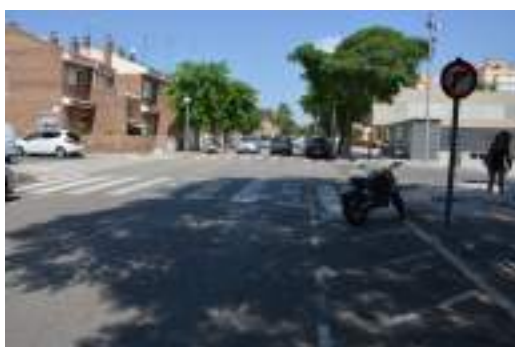
Imatge 34. Falta del pas de vianants elevat a la intersecció
