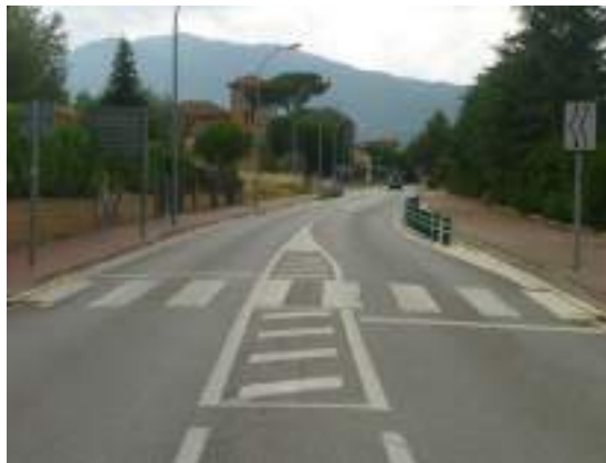
Imatge 34. Exemple de mitjana pintada, estrenyent els carrils de circulació per moderar la velocitat. Aquí s'ha combinat amb trencament horitzontal de l'eix de la trajectòria.
