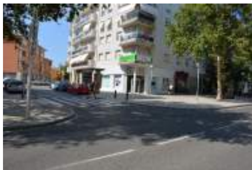
Imatge 55. No s'ha establert un pas de vianants completant la intersecció.
