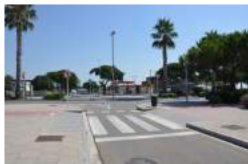
Imatge 24. Passos accessibles, però sense senyalització S-13 prèvia.
