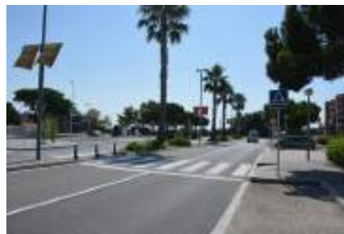
Imatge 22. Passos de vianants a la intersecció
