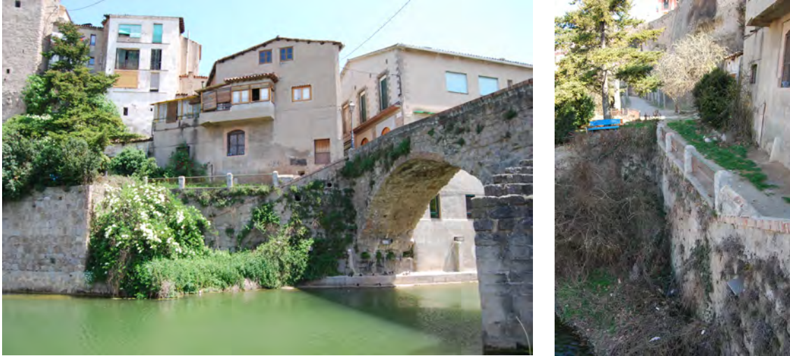
L'accés al camí de Cal Metre des del carrer del Pont Vell.
