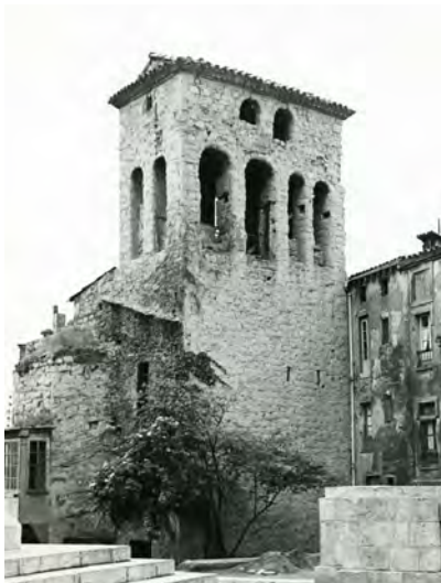
El campanar i l'absis de l'antiga església de Santa Eulàlia, abans de les intervencions del Servei.
