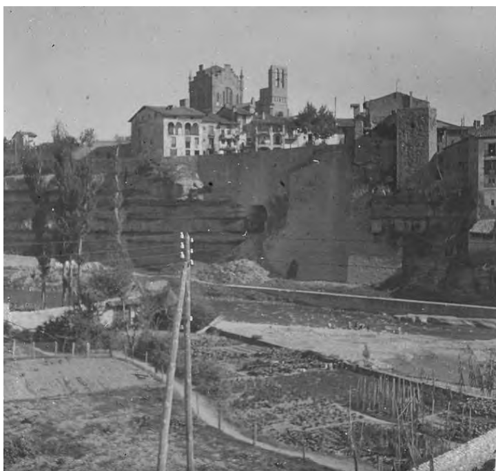
Vista de la muralla del castell i del mur de contenció
