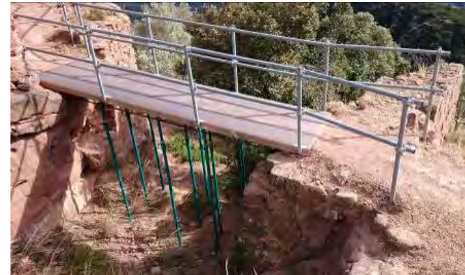
Pont d'accés al recinte sobirà.
