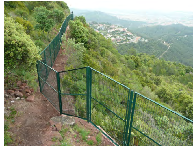
Tanca perimetral en la vessant de migdia del turó.
