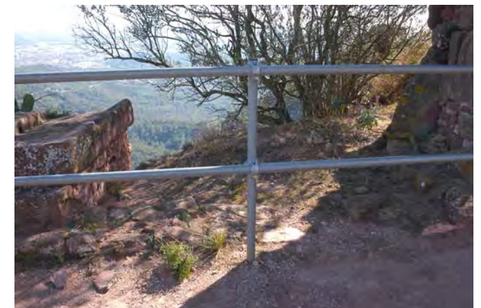
Detall de les baranes de protecció dels recorreguts de les visites al recinte sobirà.
