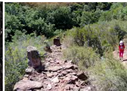
3.- Mur de contenció i paviment de pedra
