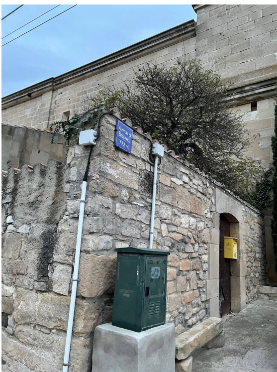
Façana a Plaça esglesia. Accés al pati
