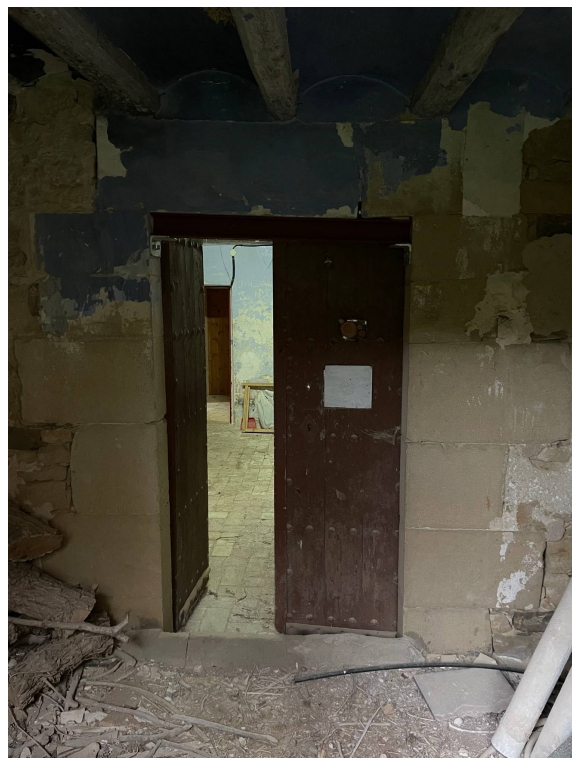
Porta d'accés des del porxo a l'interior del local
