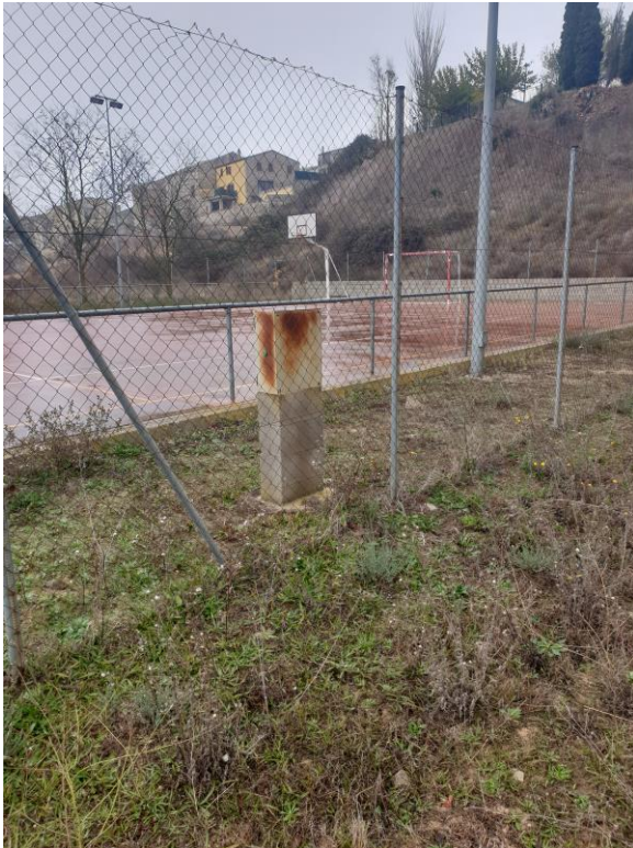
Foto 04.1 Quadre elèctric existent zona esportiva Connexió nou cablejat.
