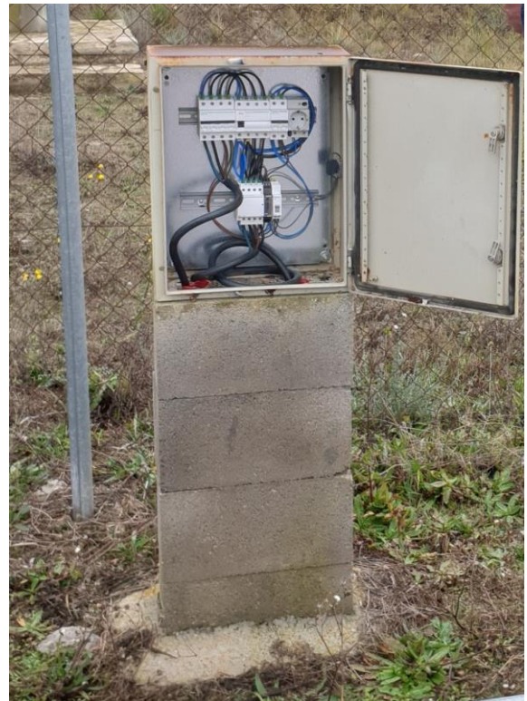
Foto 04.2 Quadre elèctric existent zona esportiva Connexió nou cablejat.
