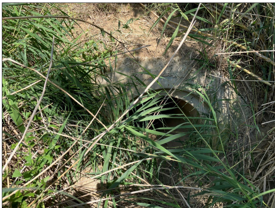
Figura 9. Obra de drenatge del torrent dels Horts sota la via del ferrocarril.
