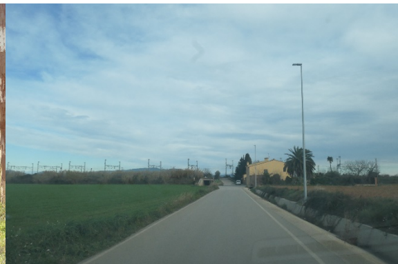
Carretera del Riberal, tramo entre el núcleo urbano y el paso bajo el ferrocarril, que dispone de alumbrado
