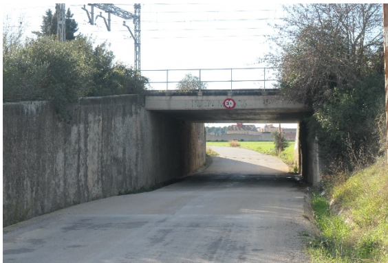
Carretera del Riberal, paso bajo el ferrocarril
