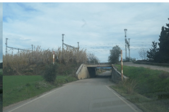
Carretera del Riberal, paso bajo el ferrocarril
