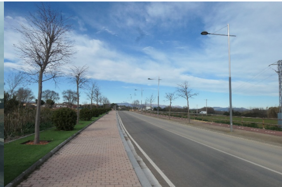
Carretera GIV-6228, tramo entre Vilamalla y el Pont del Príncep
