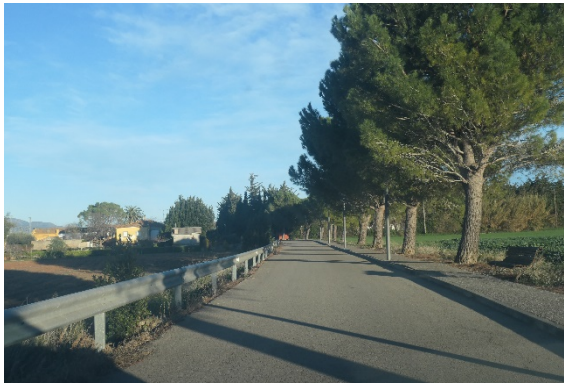
Camí de l'Estació, con acera en el lado sur
