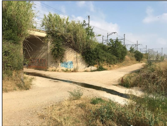
Figura 5. Vista de l'obra de drenatge de la línia del Ferrocarril Barcelona-Portbou sobre el Regatim
