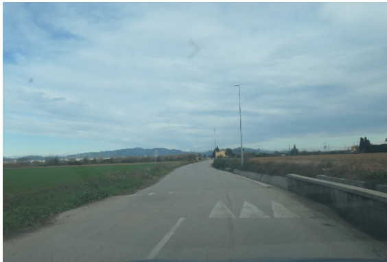
Carretera del Riberal, elementos de reducción de la velocidad en la zona próxima al núcleo de Vilamalla
