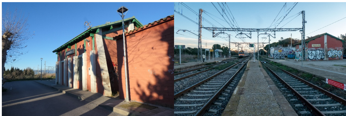
Edificio de viajeros de la estación de Vilamallà de ferrocarril
