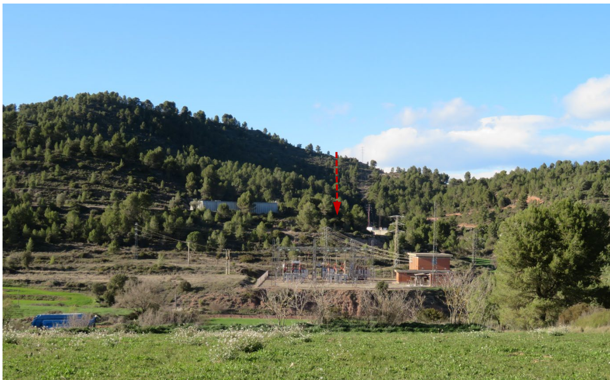
Vista des del sud de l'emplaçament previst pel dipòsit. Març 2020
