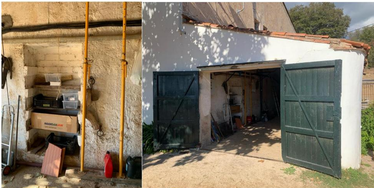
Vista de la porta tapiada i convertida en lleixes, que es pretén obrir de nou per connectar els dos espais). Vista de l'actual porta d'accés al magatzem. Aquest tros de mur i el punt rodó que fa es conservaran ja que el considerem característic de la masia.
