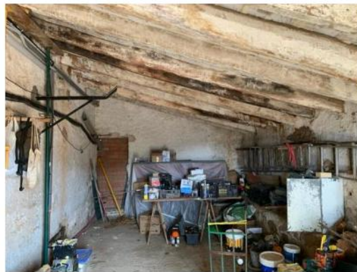
Estat actual del porxo a reformar i fotografia interior on es pot apreciar l'estat deteriorat de la coberta a restaurar.
