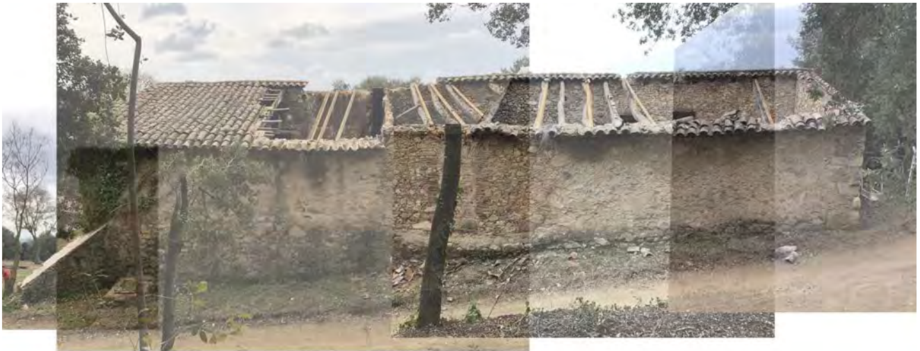
Fachada nordeste estado inicial
