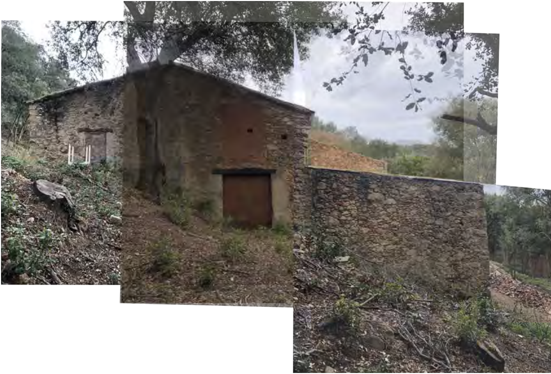
Fachada noroeste estado inicial
