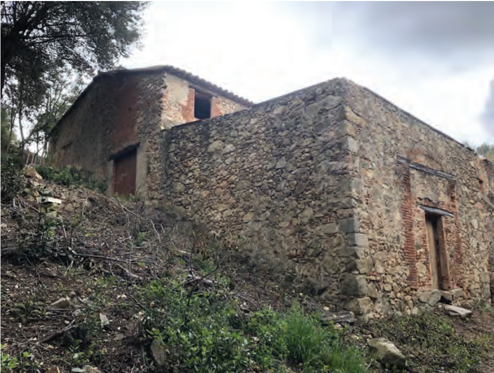
Perspectiva de las fachadas noroeste y sudoeste estado actual
