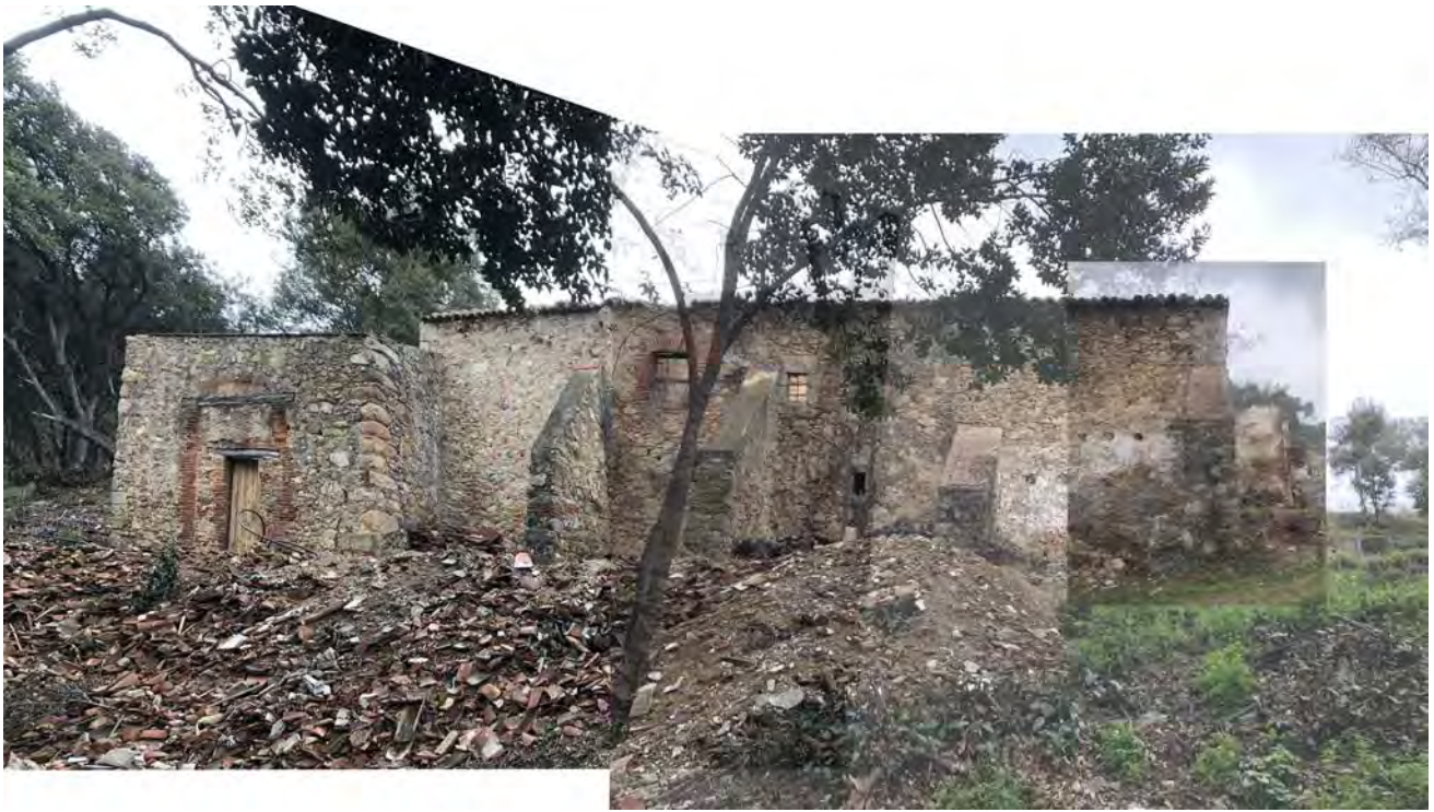
Fachada sudoeste estado actual
