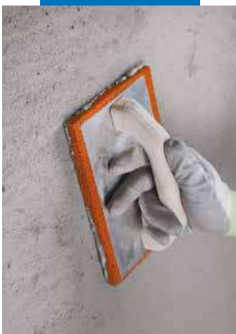
Fratasado de Planitop Rasa & Ripara
