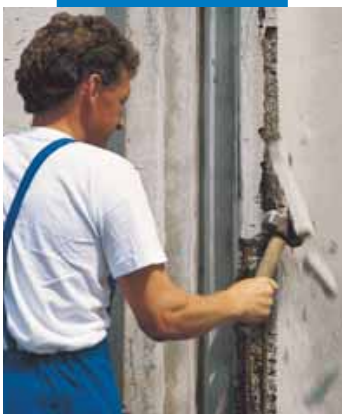
Demolición del hormigón degradado
