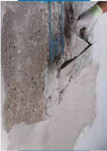
Aplicación con paleta de Planitop Rasa & Ripara
