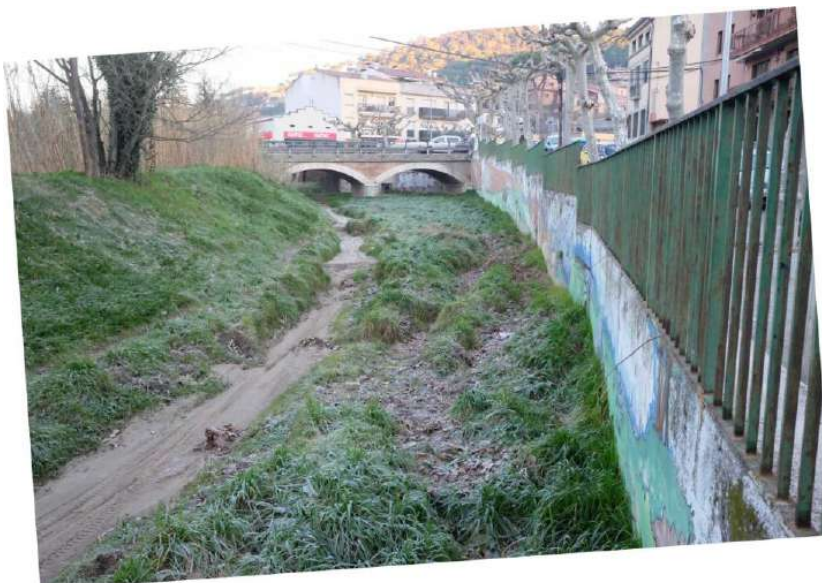
Riera del Far, a l'alçada del carrer Pau Casals
