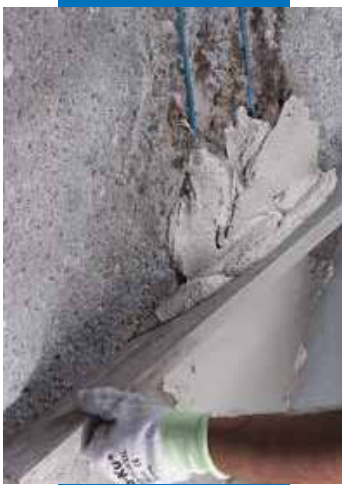
Regleado de Planitop Rasa & Ripara
