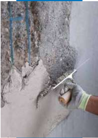
Aplicación con llana de Planitop Rasa & Ripara
