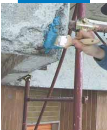
Aplicación a brocha de Mapefer 1K sobre los hierros de la armadura en un balcón de hormigón armado
