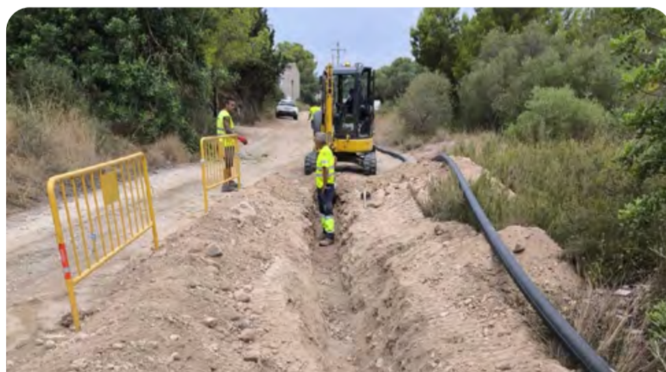
Obras de mejora en la red de distribución de agua en el municipio
