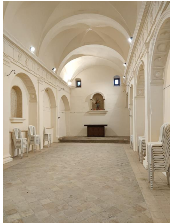
Imatge 25. Interior de la Capella del Roser. Font: elaboració pròpia.
