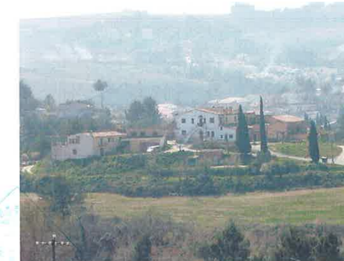
2) Vista de l'edifici
