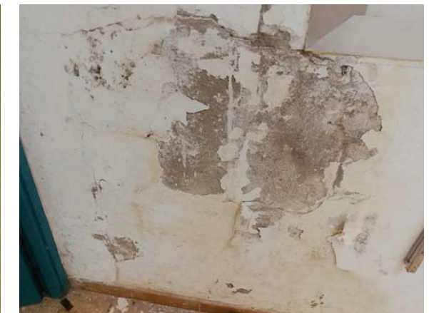
In 17: Detall de la taca d'humitat.
