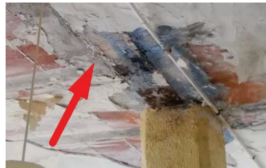
In 9: Vista de la jàssera HEB-160
