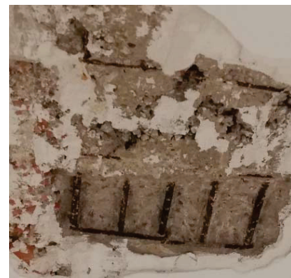
In 12: Cala on s'aprecia la disposició de l'estrebat
