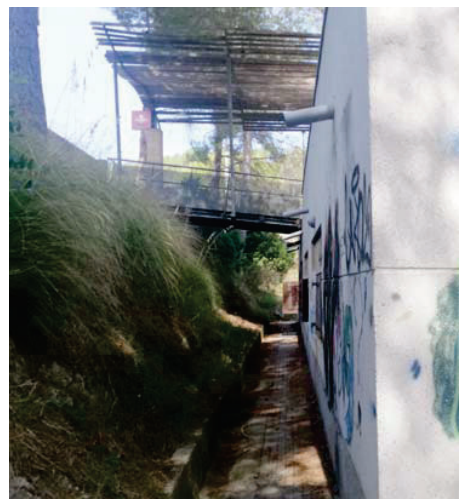
In 2: Façana a carrer de L'Àliga. Es veu la passarel·la des de el carrer.
