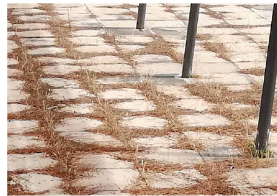
In 22: Acumulació de fullaraca i vegetació entre les juntes del sòl tècnic de la terrassa.
