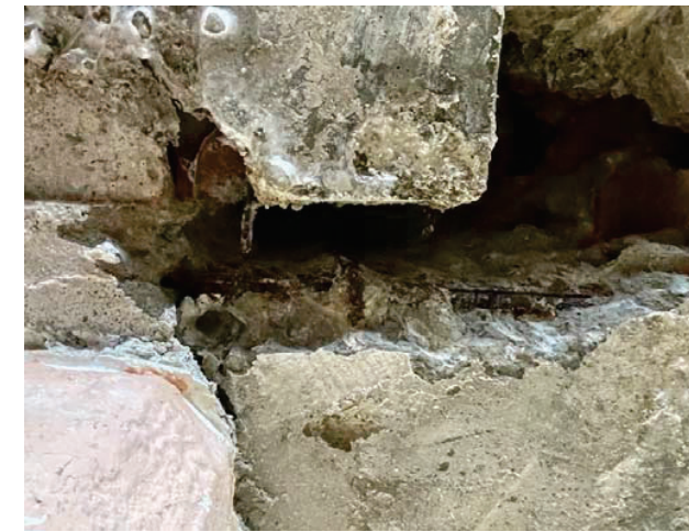
In 13: Detall de cala en forjat. Es veu la base d'una bigueta.
