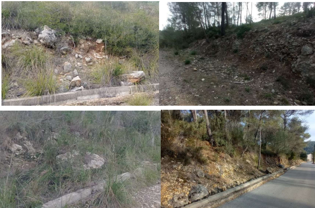
Fig. 2.6.- Exemples de caigudes de blocs de baixa molt baixa entitat i al llarg dels talussos existents a la zona (Fotos: febrer de 2023)
