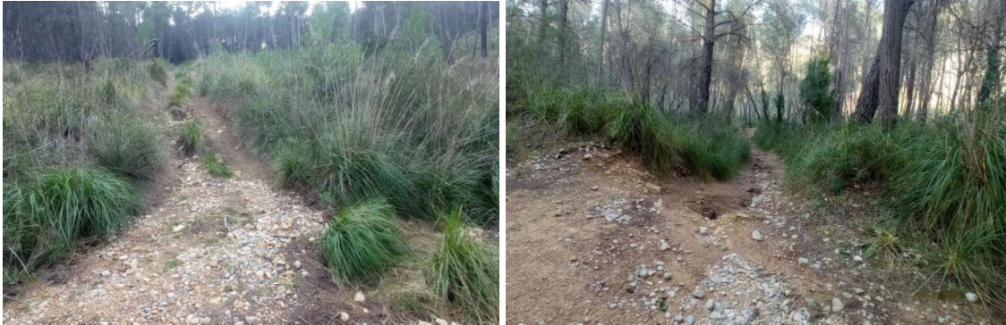
Fig. 2.10.- Trams amb erosió associada a l'escorrentiu superficial (Fotos: febrer de 2023)
