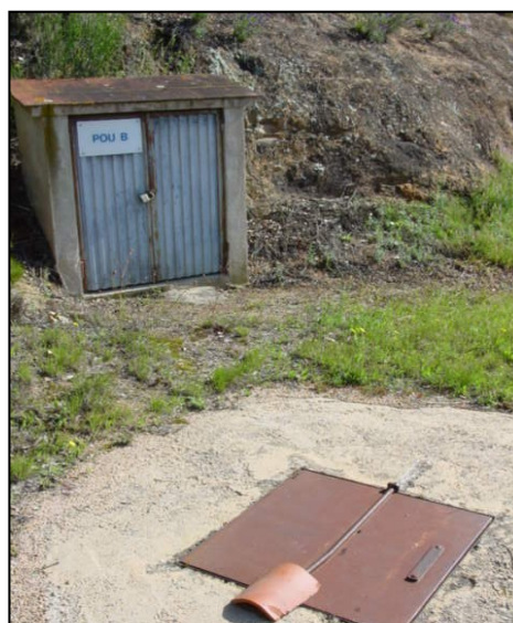
Arqueta i caseta del Pou B
