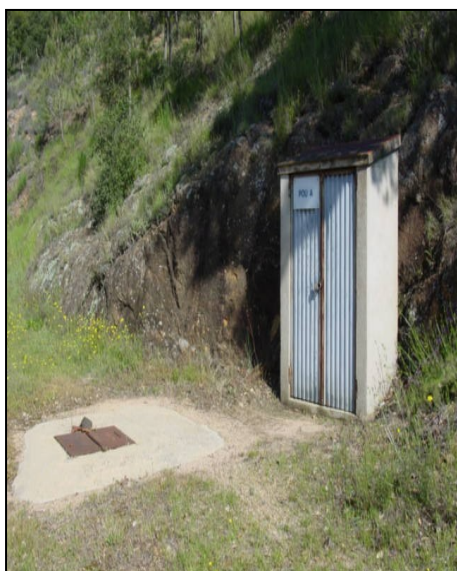
Arqueta i caseta del Pou A
