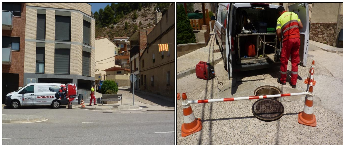
Figura 17. Inspecció amb càmera CCTV. Municipi de Jorba.
