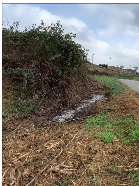
Figura 44. Abocament d'aigües residuals i habitatges connectats al col·lector
